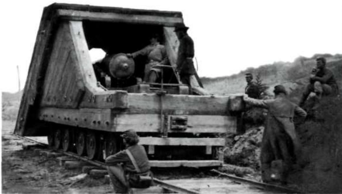
Данная машина приняла участие в сражении близ станции Саваж в Вирджинии летом 1862-го года. Армия Союза в 1864-м году сделала бронепоезд больших размеров, оснащённый орудием Паррота. Во время осады Виксбурга, 13-дюймовая мортира была поставлена на поезд.
